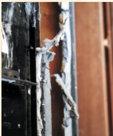
Mousse isolante de calfeutrement très légère, compressible et élastique.
