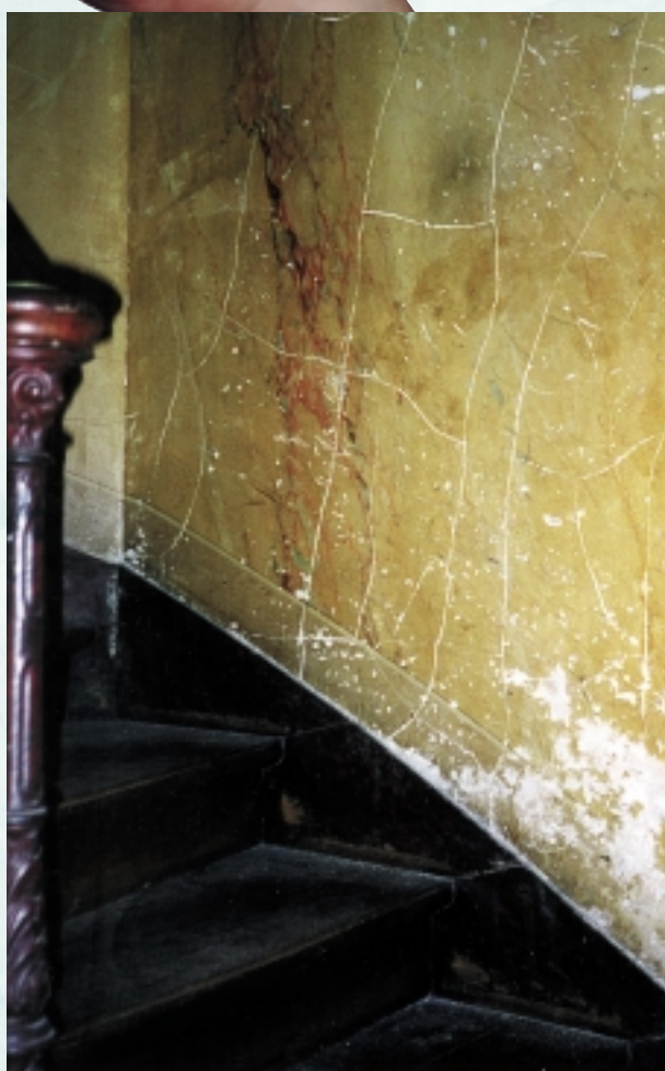
Peinture dégradée contenant du plomb susceptible de provoquer des intoxications.
