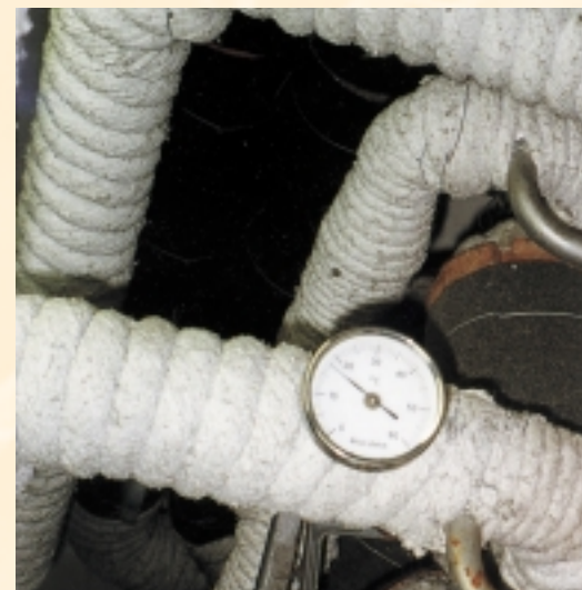
Calorifugeage à base d'amiante : Enveloppes isolantes contre les déperditions calorifiques.
