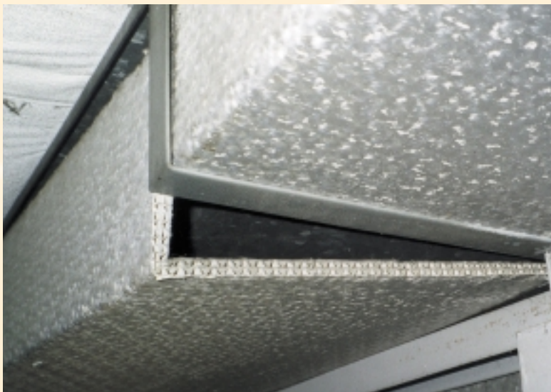
Utilisation de plaques cartonnées pour une gaine.
